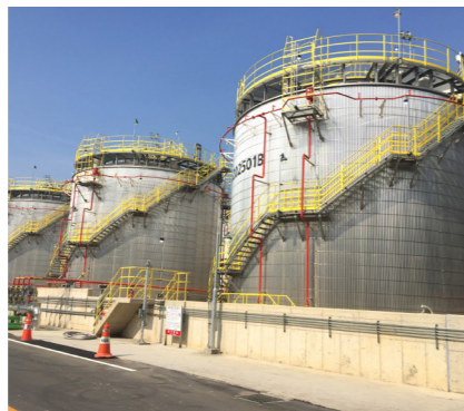
금속 저장탱크 제작 · 설치
