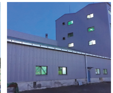
건축물 외장재(Panel) 공사
