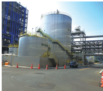
Tank Terminal 건설공사
